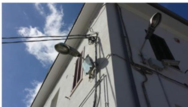
Figura 3 - Apparecchi di Illuminazione con sbraccio a muro, corpi non cut-off e lampade a bassa efficienza luminosa.
